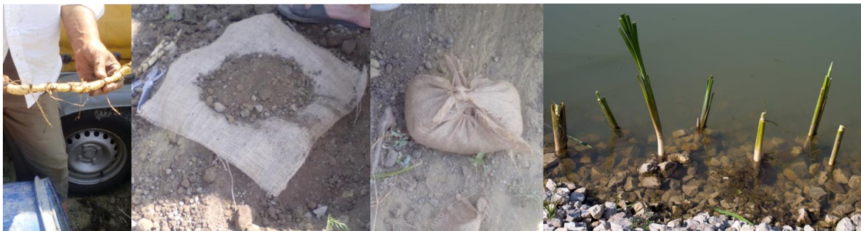
2. ábra: A képsor (balról jobbra) a mocsári növények ültetési folyamatát és módszerét mutatja be, a kőszórásos rézsűfelületek esetében
